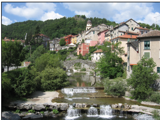
◦ Voltaggio: Il borgo ed il ponte romano.
